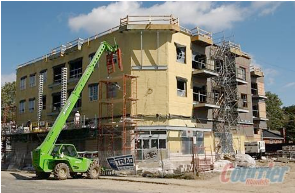
Sur le site du futur projet Place Alizés, les travaux sont déjà en cours. @cp:Photo:Jacques Pharand Photo:Jacques Pharand
