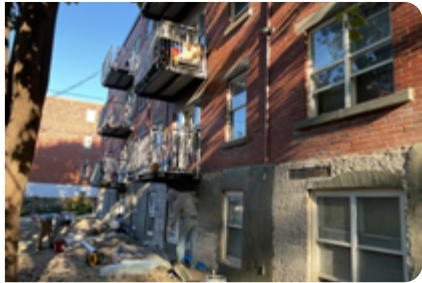
Travaux de la maison de chambres Théodore. Photo : SHDM
